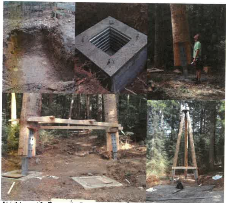
Abbildung 10: Baustelle Baumkronenlehrpfad Neuschönau
