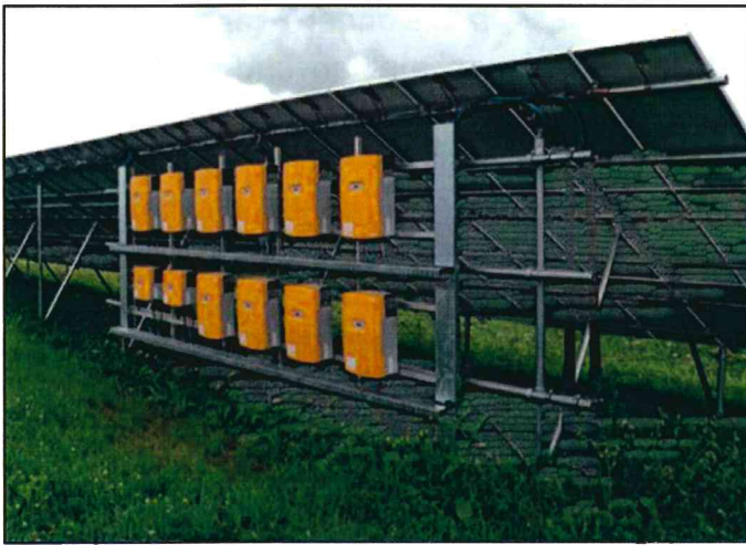
Abbildung 7: extensives Grünland auch im Schattenbereich der Module, Foto: ALTUS
