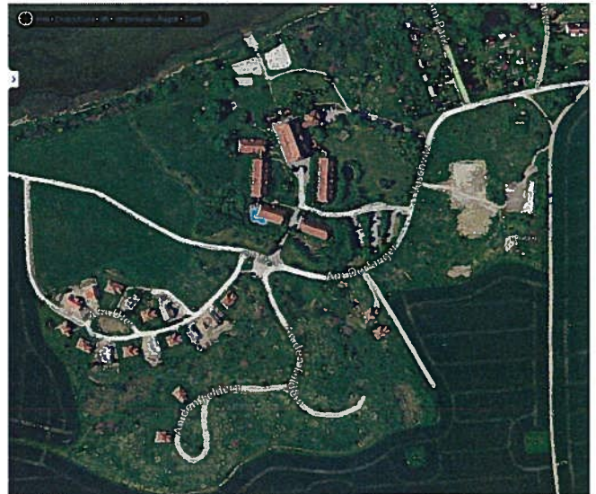
Abbildung 1: Luftbild vor Wiederaufnahme der Bauarbeiten
