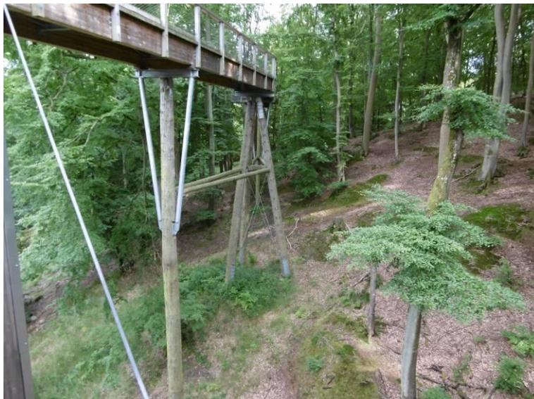
Foto 1 Der Steg wird von den tragenden Holzstützen in Form von Dreiecksstützen bzw. zusätzlichen Stützen als Kopfbänder getragen. Die Holzstützen sind kaum noch von den Baumstämmen des Waldbestandes zu unterscheiden.
