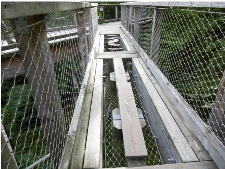
Foto 3 Es wurden einzelne Stationen in den Pfadverlauf eingebunden, in denen die Besucher über den Abgrund balancieren können. Auch hier sind primär Holzkonstruktionen und Edelstahlgitter zur Erreichung einer Transparenz der Anlage verwendet worden.
