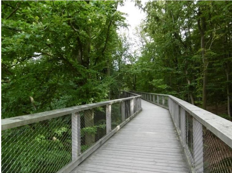
Foto 2 Hier der Pfadverlauf zum Baumwipfelpfad Prora. Der Steg und das Geländer sind aus Holz gearbeitet. Edelstahlgitter bilden die Geländerfüllung und unterstreichen die Transparenz der Anlage. Damit haben auch Rollstuhlfahrer freie Sicht in die umgebenden Waldbestände.
