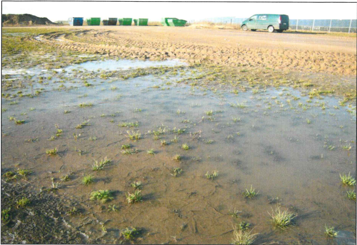
Abbildung 4: Aufgrund der Bodenverdichtungen bildet sich Staunässe.
