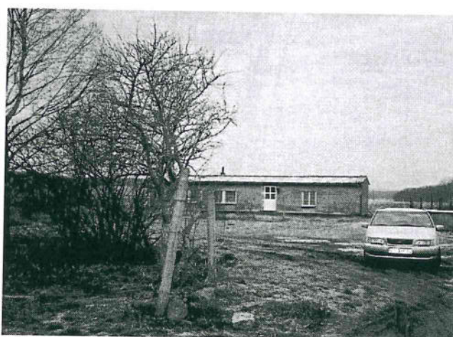
ehemaliges Vereinsgebäude des Taubenzüchtervereins
