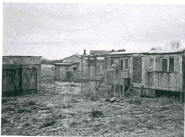
Nebengebäude, Bauwagen im südlichen Teil der Fläche
