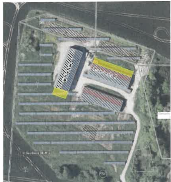
Abbildung 1: Solaranlage mit Erweiterungsbe- reichen der Anlehnhallen (gelb); Quelle Luftbild: geodienste.lk-vr.de
