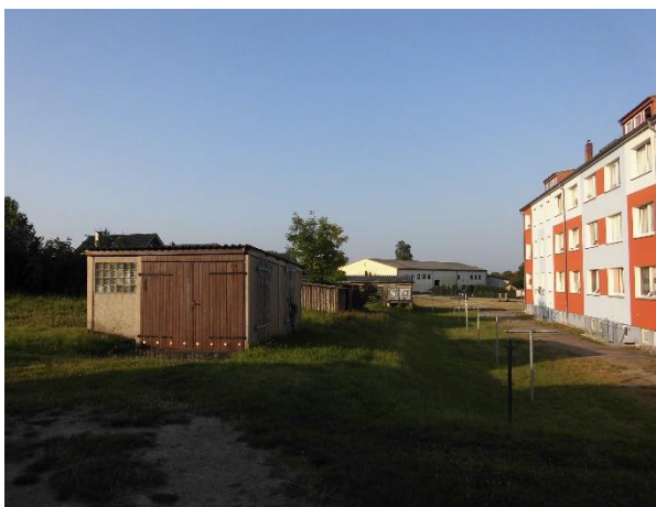
Nebenanlagen: Garagen/Schuppen/Gartenhäuser, eig. Aufn.
