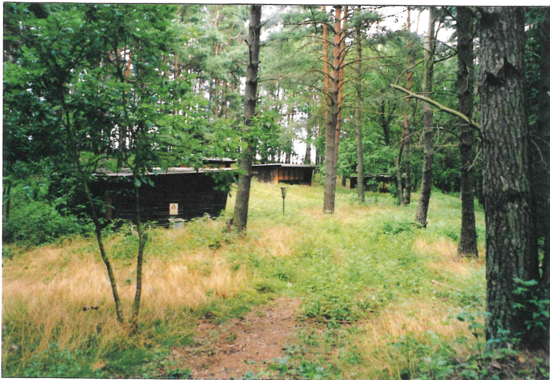
Bereich der abzureißenden Alt – Ferienhäuser
