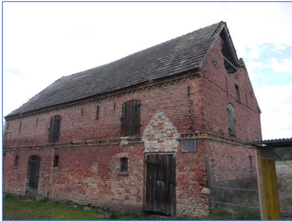
Abb. 16 Ausweichgebäude für Rauch-schwalben mit bestehender Besiedlung.
