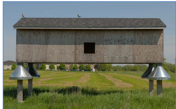
Abb. 18 Alternatives Rauchschwalbenhaus (Abmessungen mind. Höhe 4 m, Grundfläche mind. 4 x 2,5 m).
