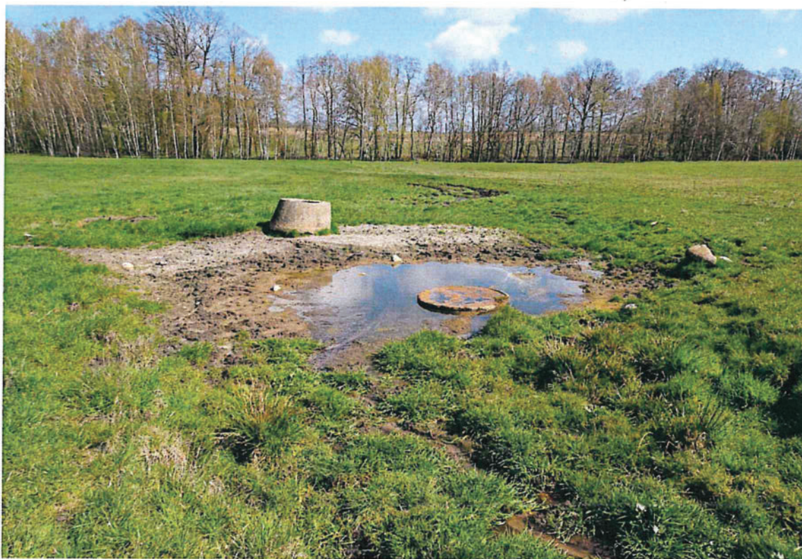
Abbildung 8: Im Westen der Vorhabenfläche befinden sich Nassstellen im Bereich eines Drainageschachtes.
