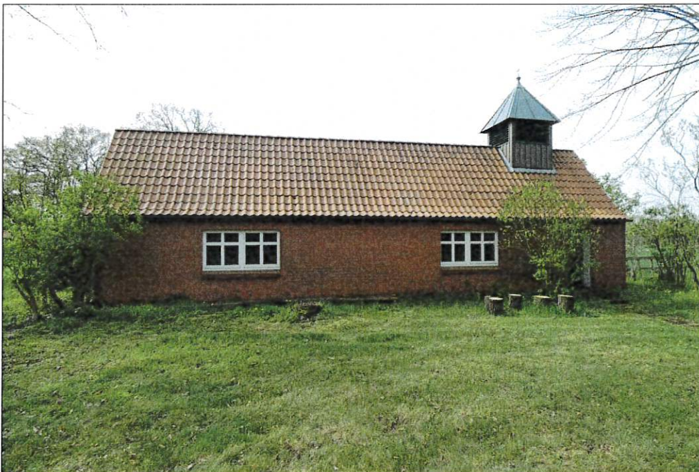
Abbildung 4: Ansicht der ehemaligen Kapelle aus Richtung Norden, davor Zierrasen.
