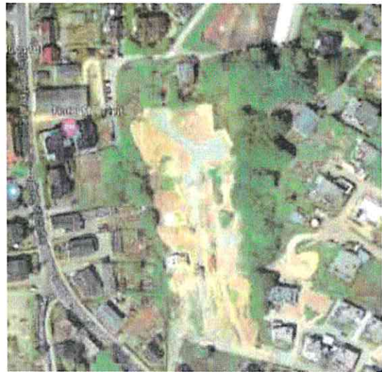
Abbildung 7: Luftbild 2018 mit weitgehend fertiggestellten Erschließungsarbeiten und ersten Baustellen von Wohngebäuden westlich der Erschließungsstraße
