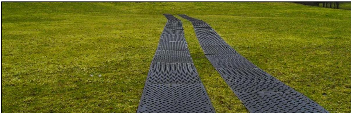
**Abbildung 12:** Beispielfoto mobile Baustraße zur Vermeidung von Bodenverdichtung (<https://www.securatek.de/Referenzen/s-tek-48-Hochleistungs-Bodenschutzplatte-als-Mobile-Baustrasse-beim-Rohrleitungsbau-bei-Creussen-in-Bayern>)
