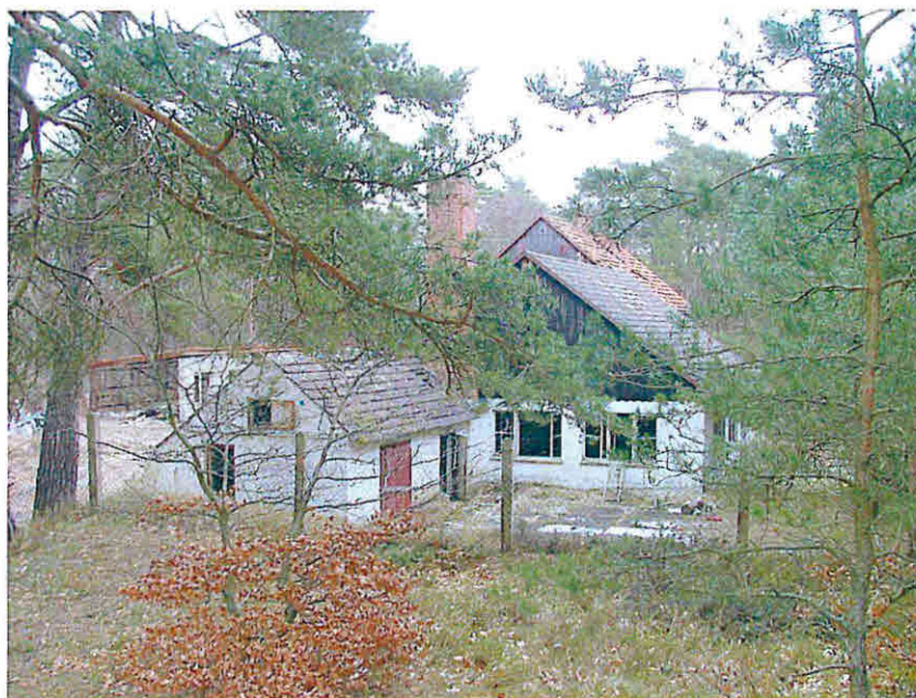
Bild 3: ehemaliges Ferienhaus der Fluggesellschaft „Interflug“
