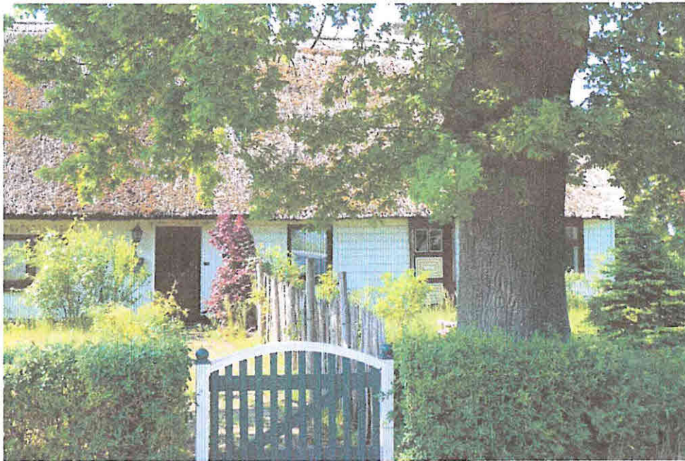
Traufständiger Altbestand im Plangebiet mit vorgelagerten halbprivaten Grünräumen (Quelle: Foto d.V.)
