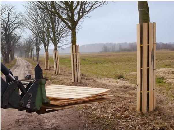
Stammschutz: lückenlose Verschalung des Baumstammes mithilfe von Holzbrettern; als Polsterelemente zwischen Stamm und Brettern dienen z. B. alte Autoreifen, Jutesäcke etc.
