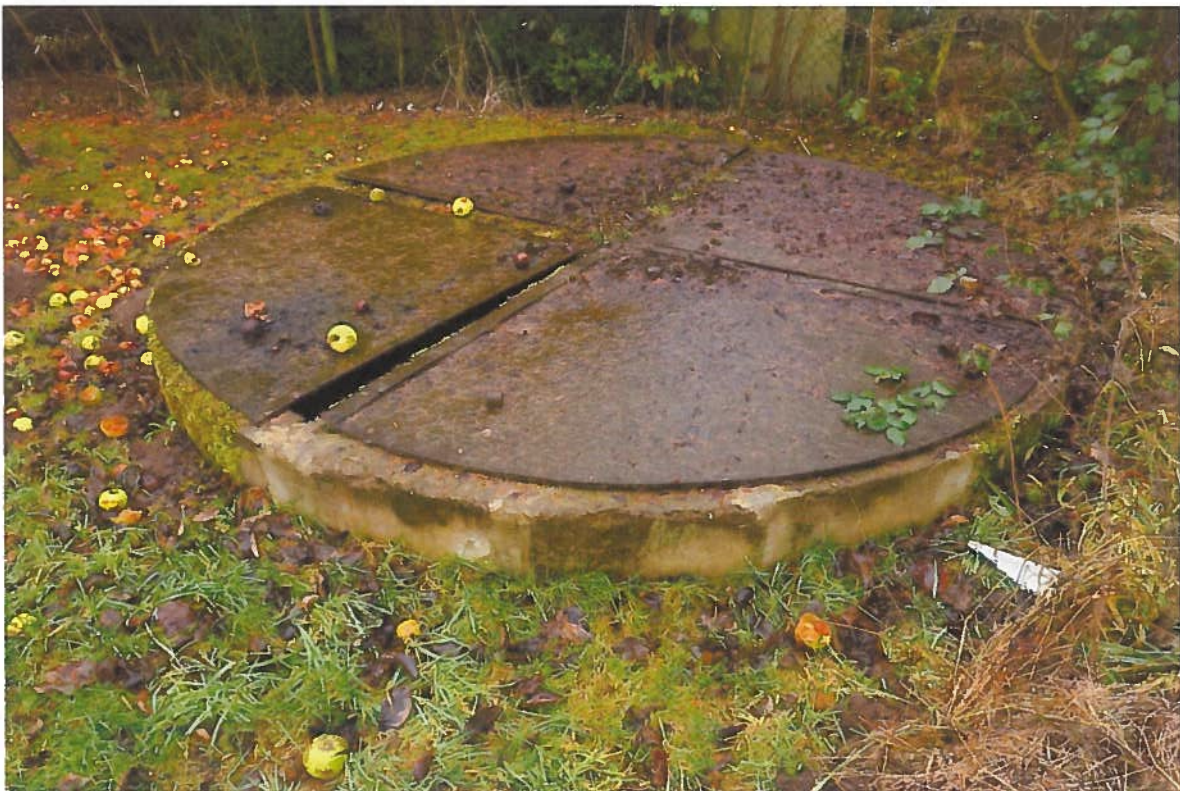
Abbildung 13: Abwassersammelgrube A4.
