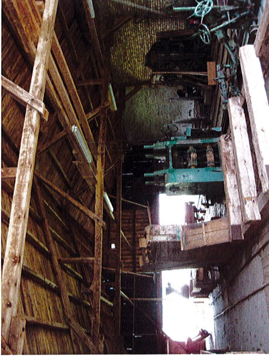
Abbildung 7: Dachkonstruktion im Sägewerk ohne Hohlräume
