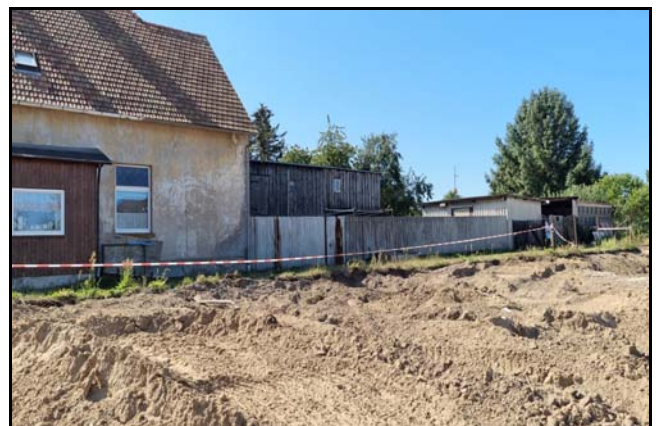
Abb. 6: Ansicht der südöstlichen Grundstücksgrenze des B-Plangebietes; auf dem Nachbaugrundstück bestehen Sichtschutzwände sowie Schuppendächer und -wände aus Asbestzementwellplatten
