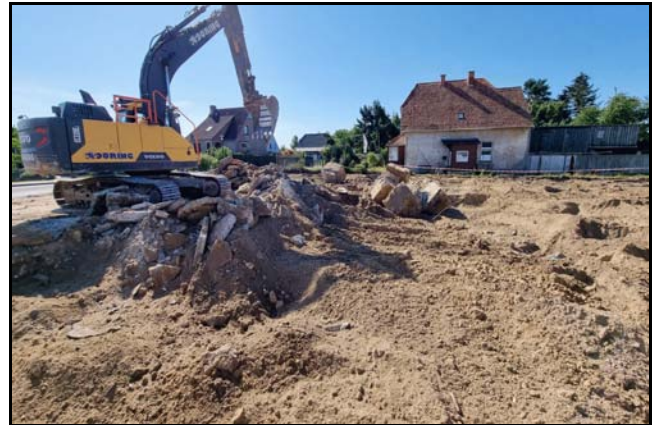
Abb. 4: Teilfläche 3 zum Zeitpunkt der Bodenprobenahmen; in diesem Bereich erfolgte die Verladung der letzten Betonfundamente
