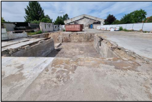
Abb. 1: Ansicht des B-Plangebietes von Ost nach West nach der Beseitigung des Brandschutts auf der Teilfläche 2; in der Bildmitte ist der beräumte Keller und im Hintergrund die Halle auf der Teilfläche 1 erkennbar
