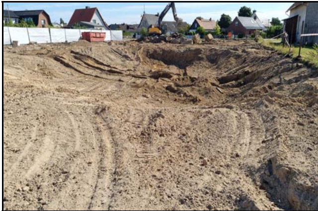
Abb. 3: Ansicht der Teilfläche 2 zum Zeitpunkt der Entnahme der Bodenproben; in der Bildmitte ist die Baugrube des zurückgebauten Kellers erkennbar
