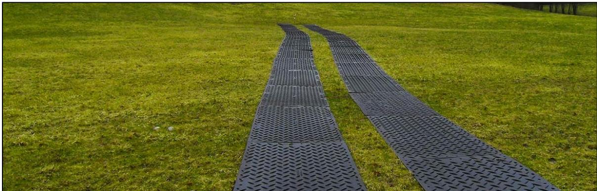
**Abbildung 11:** Beispielfoto mobile Baustraße zur Vermeidung von Bodenverdichtung (<https://www.securatek.de/Referenzen/s-tek-48-Hochleistungs-Bodenschutzplatte-als-Mobile-Baustrasse-beim-Rohrleitungsbau-bei-Creussen-in-Bayern>)
