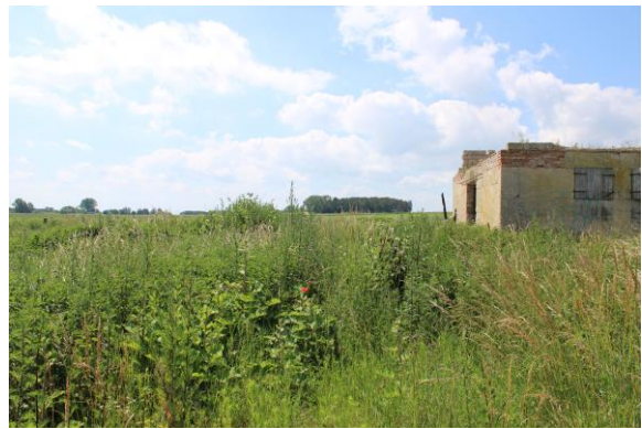
Abbildung 14 Ruine der ehemaligen LPG-Anlage
