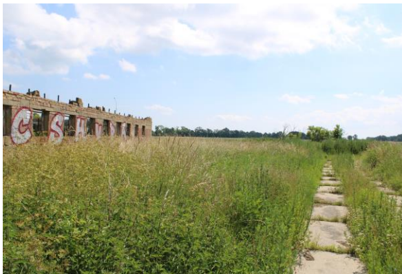
Abbildung 15 Ruine der ehemaligen LPG-Anlage
