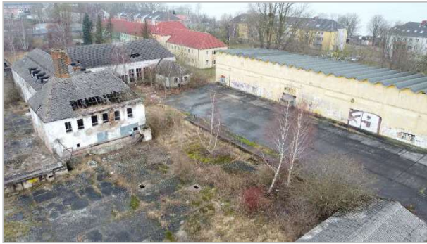
Blick auf die verfallenen Gebäude des ehemaligen LIW (Mitte)
