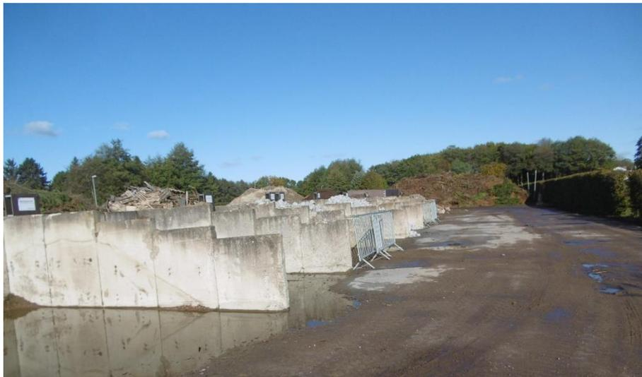
Foto 1: Die Lagerbereiche sind boxenartig durch aufrechtstehende Betonplatten abgegrenzt.
