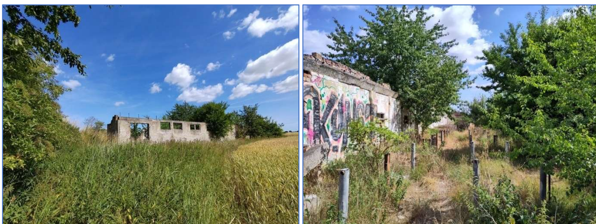
Abb. 16 und 17 Ruine eines ehem. Stallgebäudes.
