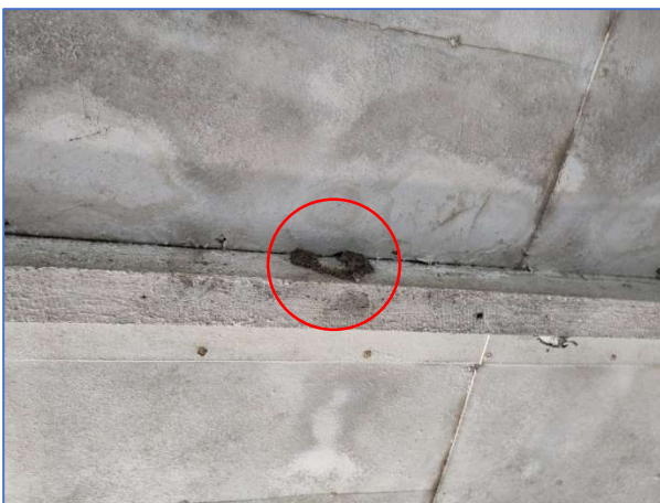
Abb. 36 Rauchschwalbennest im Stallgebäude
