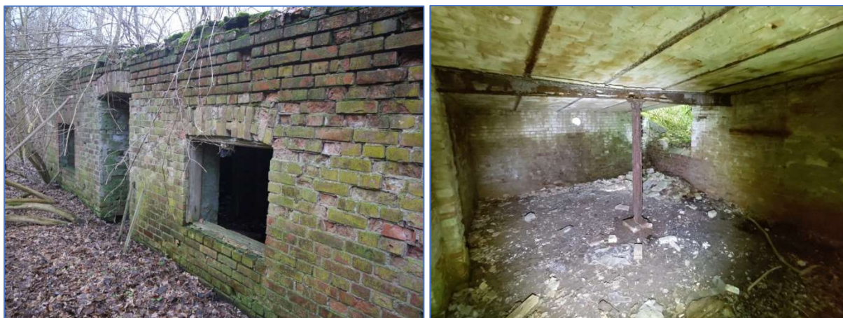
Abb. 26 und 27 Außen- und Innenansicht des Nebengebäudes.
