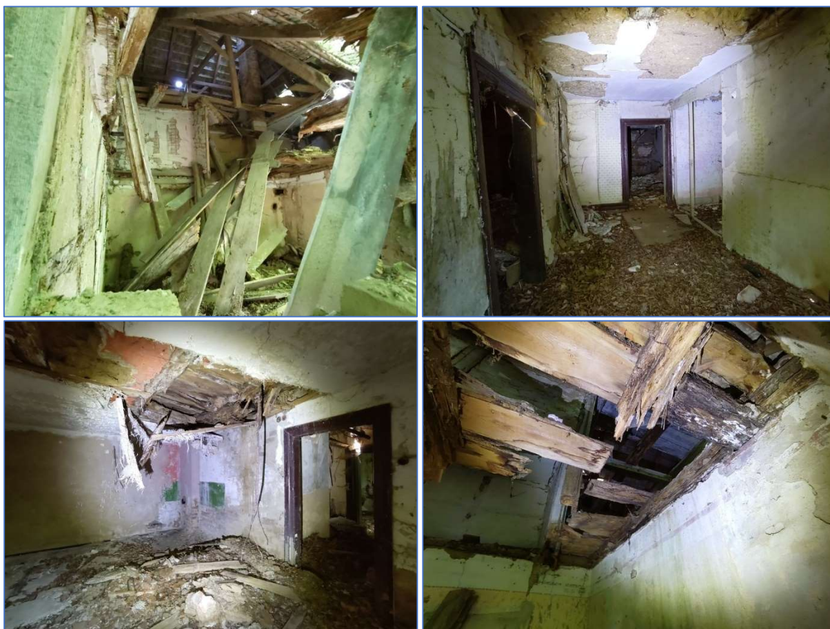
Abb. 22 bis 25 Innenräume des ehem. Gutshauses.
