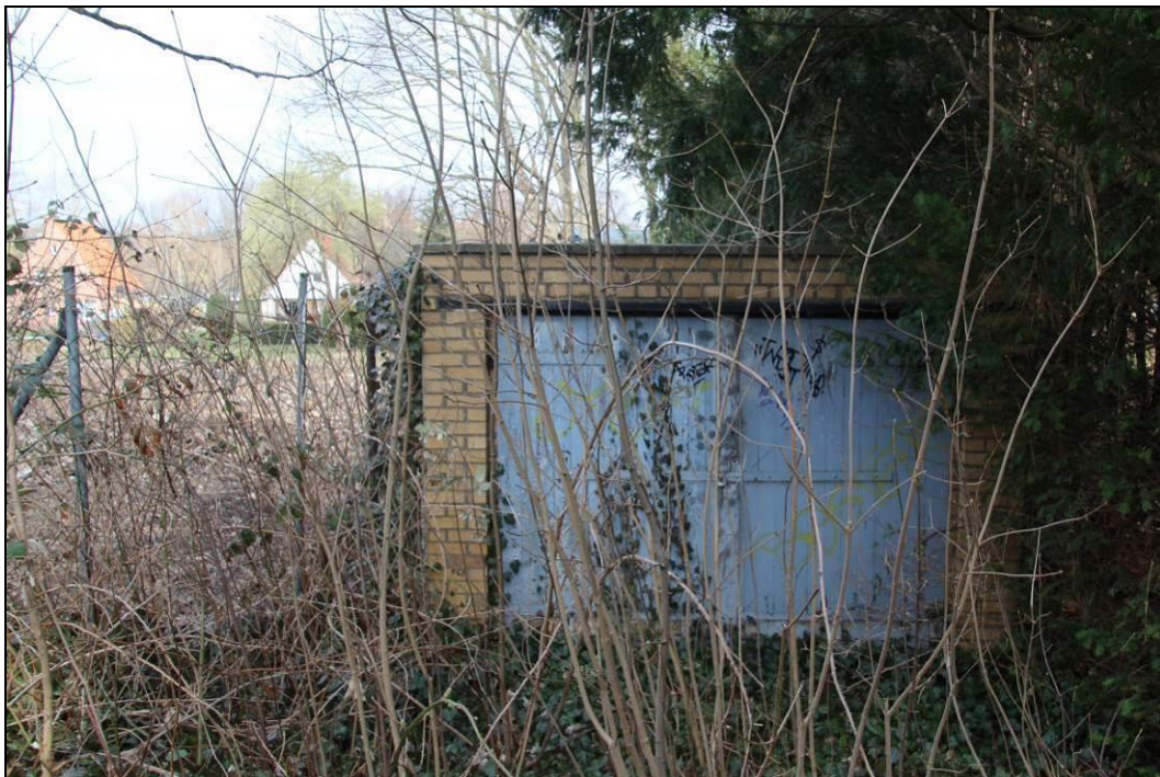
Abbildung 13: Garage im Plangeltungsbereich.
