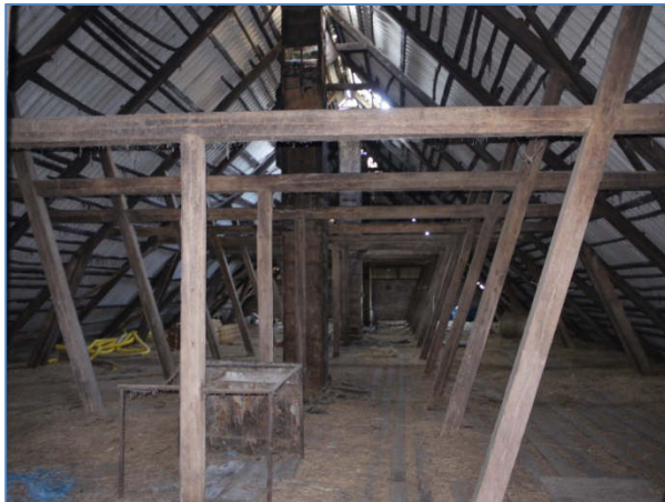
Abb. 7 Dachboden des ehem. Stallgebäudes.
