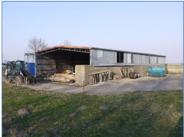
Abb. 8 Wellblechhalle, die abgebaut und dann an anderer Stelle neu errichtet werden sollte.
