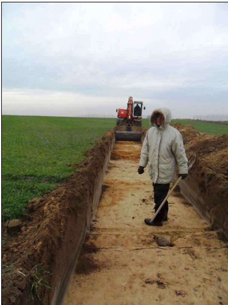
Abb. 15: Arbeitsfoto. FP 256. Anlage Baggerschnitt.
