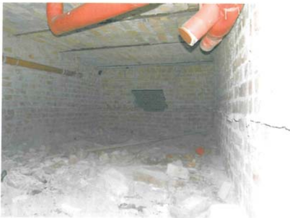
Abb. 5 Kellerbereich des nördlichen Gebäudetraktes mit mehreren mehr oder weniger abgetrennten Teilbereichen
