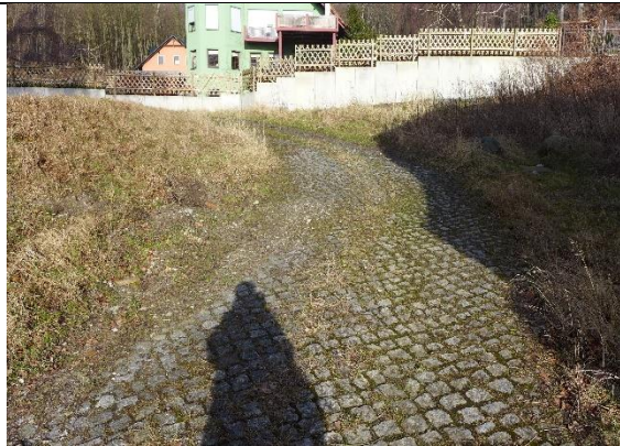
Natursteinpflaster und Garten
