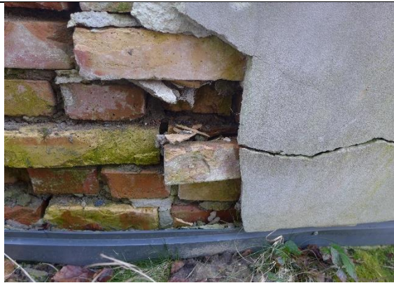
Poröses Fundament aus Ziegeln und Beton
