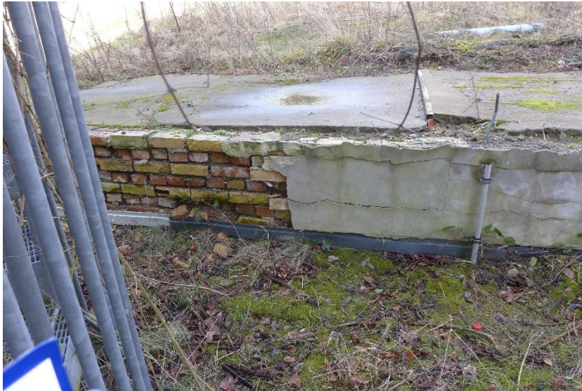
Abbildung 4: Keller- oder Fundamentreste im GB
