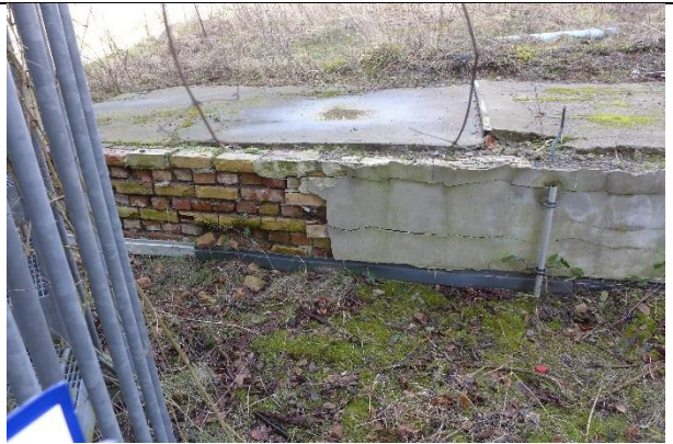
Poröses Fundament aus Ziegeln und Beton
