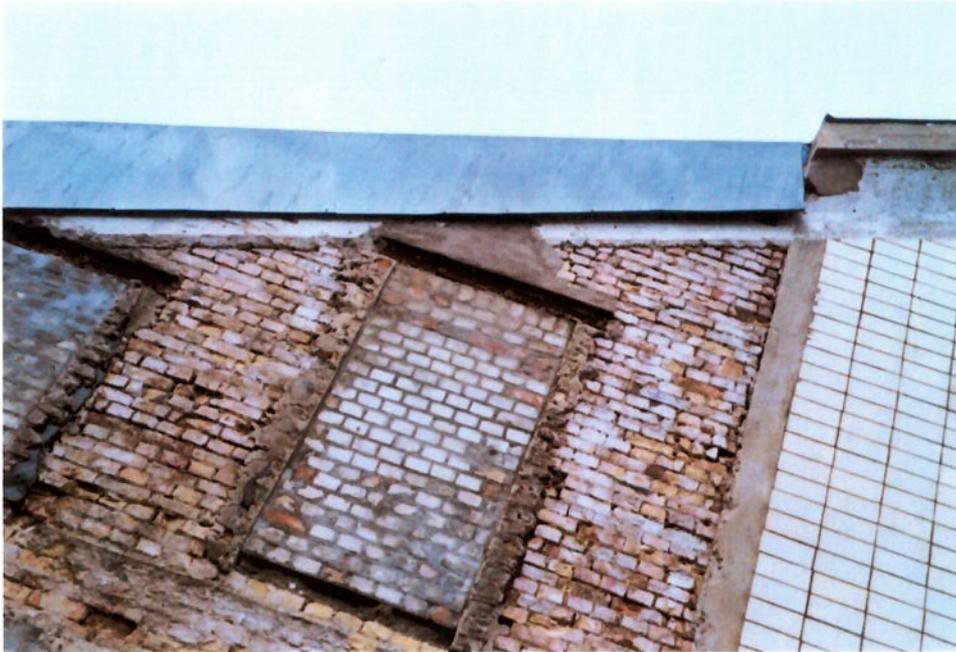
Abbildung 17 Giebelblende am Ortgang aus Blech mit Wandabstand
