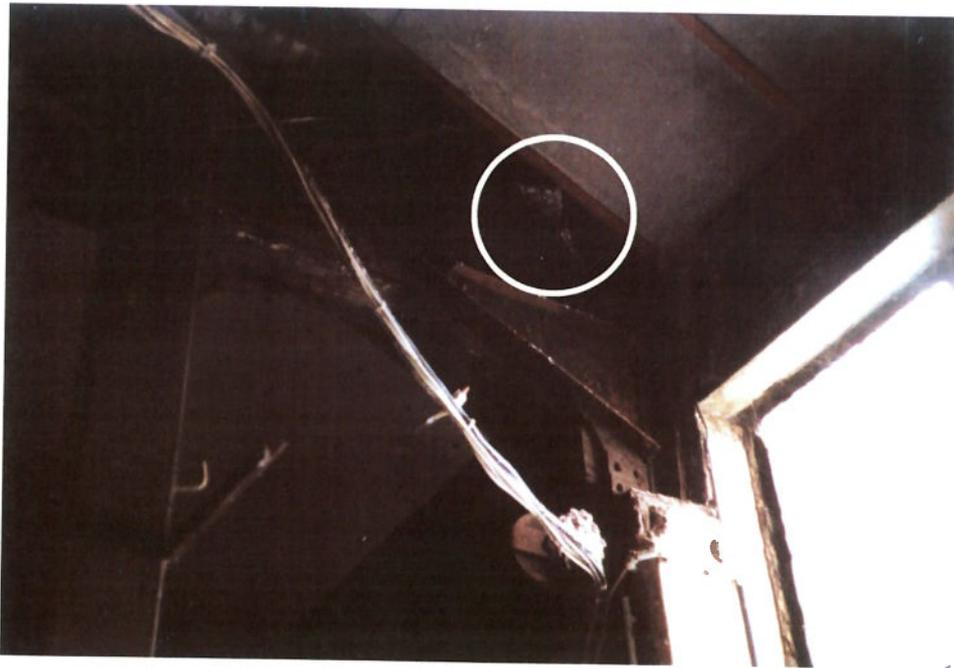
Abbildung 5 Nest im oberen Trägerbereich, Kotklumpen auf Elektrokabeln
