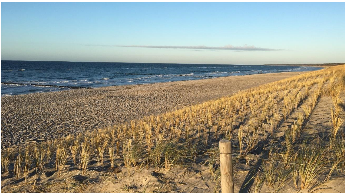
Abbildung 4: Blick auf die im Jahr 2022 neu aufgespülte Küstenschutzdüne
