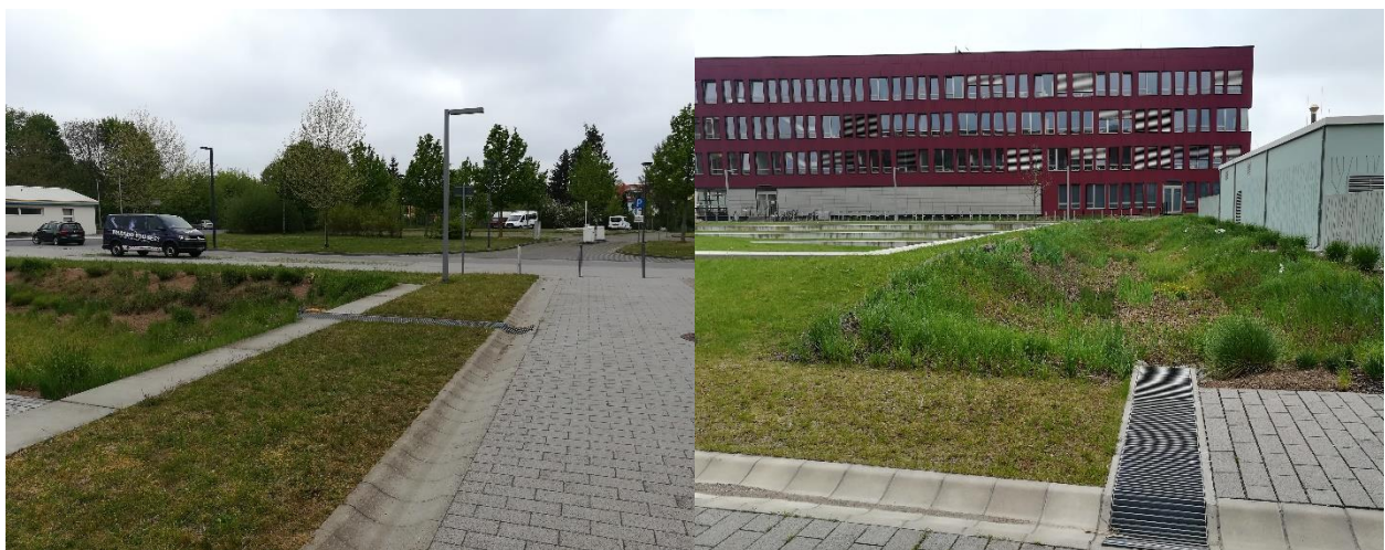
Abbildung 1-12: Beispiele für gezielte oberirdische Wasserableitung in Versickerungsmulden in der Rostocker Südstadt, Unicampus
