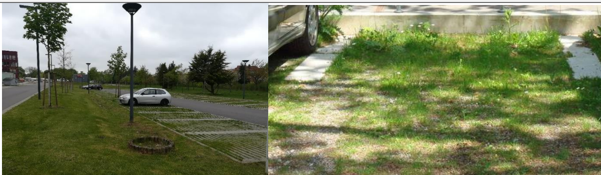
Abbildung 1-9: Beispiel für einen teilversiegelten Parkplatz mit angeschlossener Mulde in der Rostocker Südstadt, Unicampus (links) und Beispiel für Schotterrasen auf einem Parkplatz (BOKU 2019)
