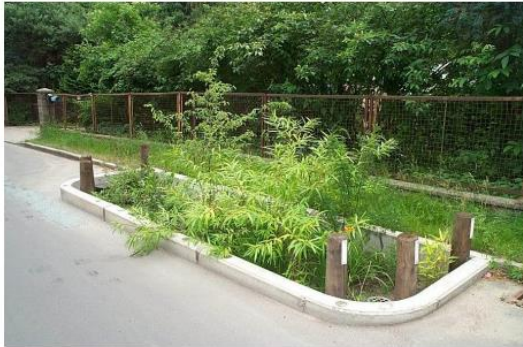
Mulden-Rigolen-Tiefbeet in Birkenstein, Brandenburg (Foto: Sieker)
