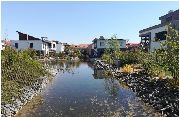
Abbildung 1-8: Beispiele für offene Wasserflächen als Regenrückhalte- und bewirtschaftungsmaßnahme in einem Wohngebiet in Leipzig-Möckern
