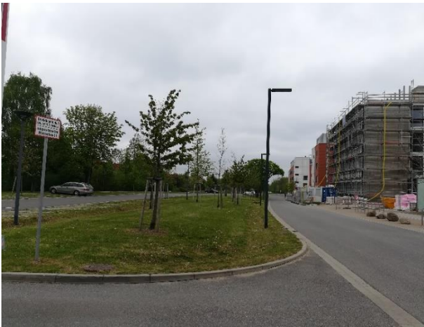
Abbildung 1-4: Beispiel für eine straßen- bzw. parkplatzbegleitende Versickerungsmulde in der Rostocker Südstadt, Unicampus
