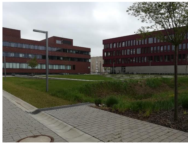
Abbildung 1-5: Beispiel für eine Versickerungsmulde die in eine Grünfläche integriert wurde (Rostock-Südstadt, Unicampus)
