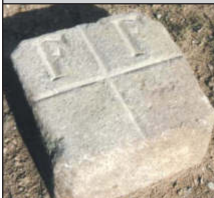
TP (Meckl.) Steinpfeiler bis 35 cm x 35 cm (auch mit Keramikbolzen)*
