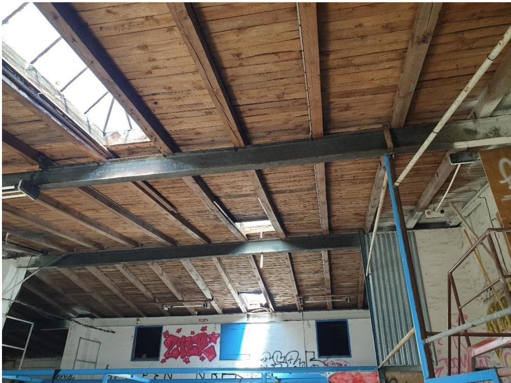
**Abbildung 5: Dachbereich des Gebäudes mit der Nummer 3. Eine Konstruktion aus Brettern und Dachpappe auf Dachsparren. Sehr hohe Temperaturschwankungen sorgen für ungünstige Bedingungen für Fledermäuse.**
