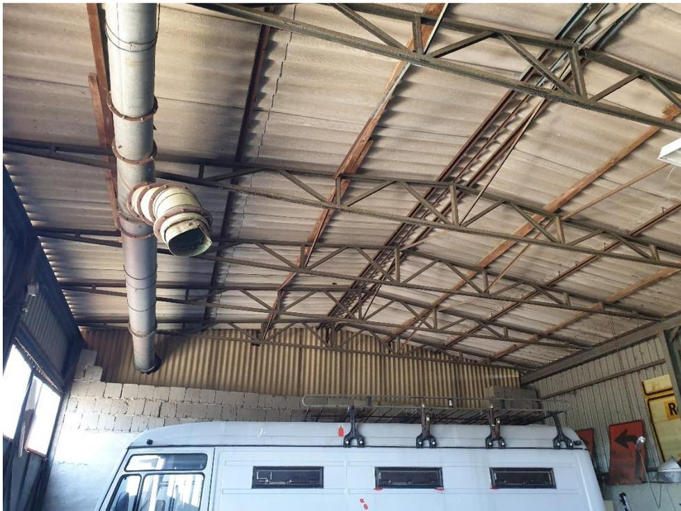
**Abbildung 6: Dachkonstruktion der Gebäude Nr. 7 bis 9. Wellasbestplatten auf Stahlgitterkonstruktion. Auch hier sind die klimatischen Bedingungen für Fledermäuse ungünstig.**
