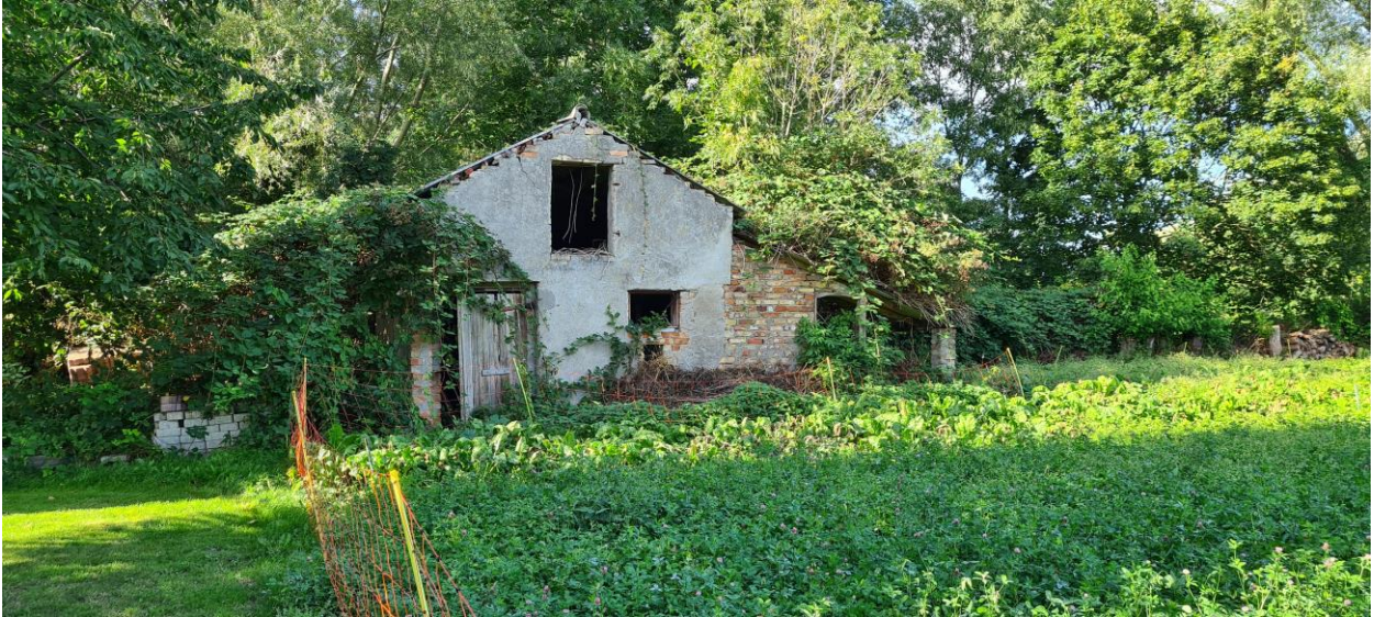
Abbildung 5: Blick auf den alten Schafstall im Westen.
