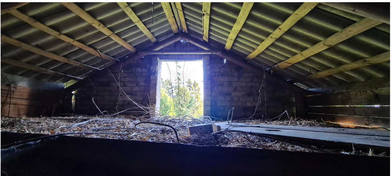
Abbildung 6: Der Dachboden im alten Schafstall.
