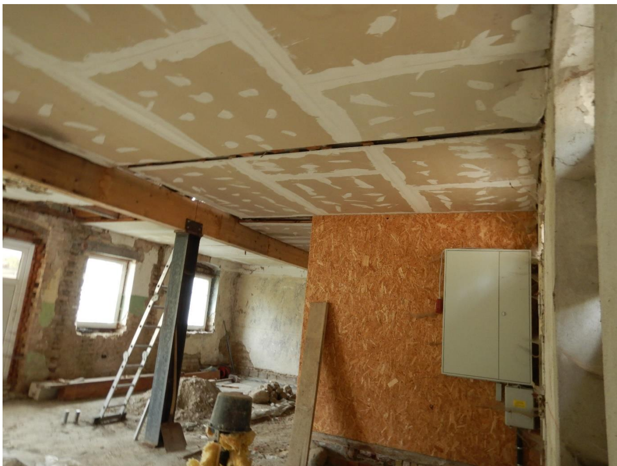
Bild 18 Verkleidungen im Erdgeschoss
