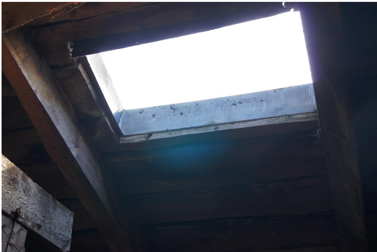
Bild 14 Dachfenster im Obergeschoss
