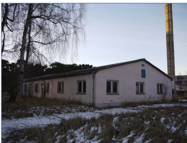
Abb. 12 Betriebsgebäude und Schornstein
