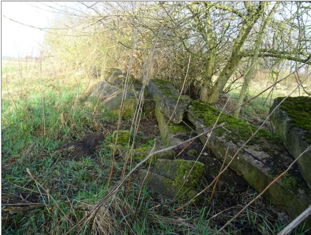
Abbildung 8: Visuelle Erfassung von Reptilien im Bereich geeigneter Strukturen - hier Betonteile der ehemaligen Schweinezuchtanlage, 21.03.2017.
