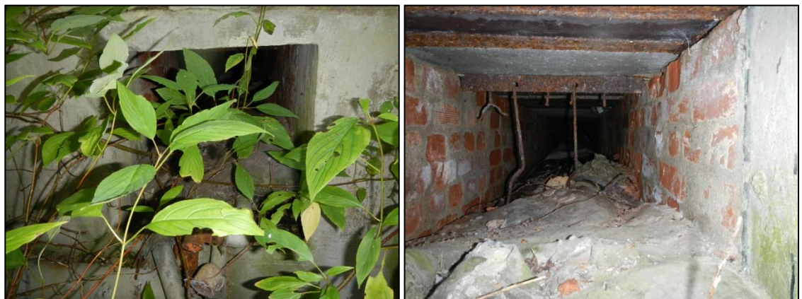
Abb. 5: Horizontaler Schacht unter der Hausruine.
