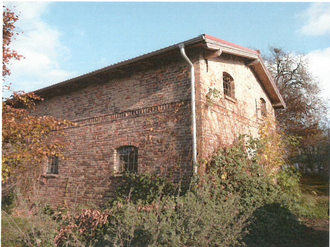
Abbildung A-12. Altes Wirtschaftsgebäude aus Backstein mit wahrscheinlicher Eignung als Sommerquartier und Wochenstube für Feldermäuse, evtl. auch als Brutplatz des Waldkauzes.
