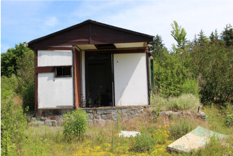
Foto 9: Parzelle 3, Laube und Terrassierung mit Bodenauf- und abtrag
