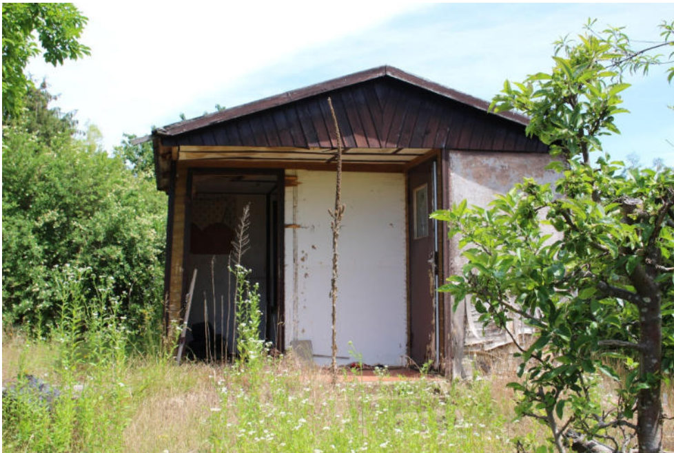
Foto 14: Parzelle 1, Laube und Geländemodellierung mit Bodenauf- und abtrag
