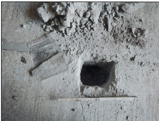
Bild 15: Lagerhalle I, Raum, Probeöffnung 23547-06, Fußbodenfugen mit asbestfreier Fugenvergussmasse.
