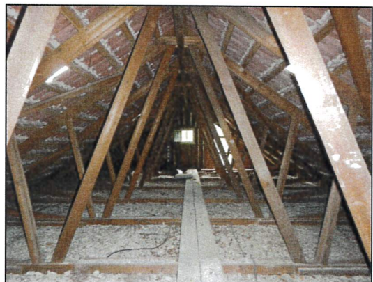
Bild 42: Wohnhaus II, Dachbodenansicht.
