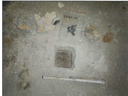
Bild 32: Bürogebäude II, EG, WC 1, Probe 23547-39, asbestfreie Bitumenpappe im Fußboden.
