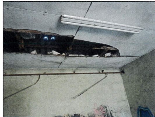
Bild 14: Garagenkomplex, Nordflügel, Garage C, Probe 23547-04, Asbestzement-Decke mit Styropor-Dämmauflage.
