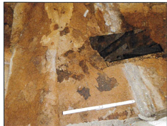
Bild 22: Wohnhaus I, EG, Wohnraum 1, Probeöffnung 23547-16, Fußboden ohne Dämmstoffe und Isolierpappen.
