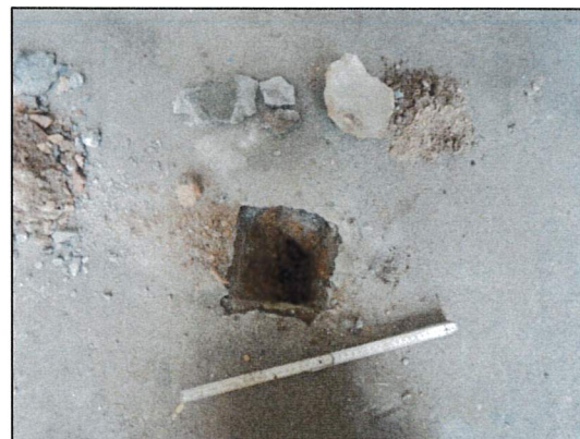
Bild 16: Garagenkomplex, Garage F, Probeöffnung 23547-07, Fußboden ohne Dämmstoffe und Isolierpappen.
