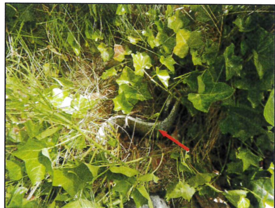
Bild 40: Gartensparte, Well-Asbestzement-Zuwegungen teilweise in den Gärten.
