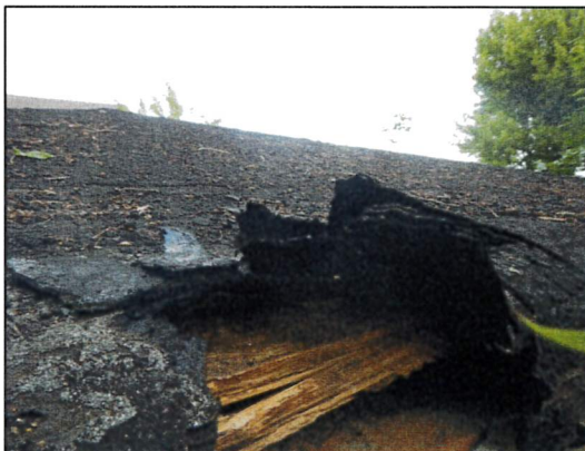
Bild 23: Wohnhaus I, Dach, Probe 23547-18, asbestfreie Teerpappe als Dacheindeckung.
