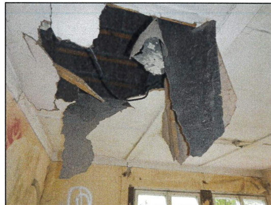
Bild 34: Wohnhaus II, Dachboden, Probe 23547-43, asbestfreie Teerpappe, Mineralwolle und Plathern (teilweise) als Dämmauflage oberhalb Presspappen-Zwischendecke
