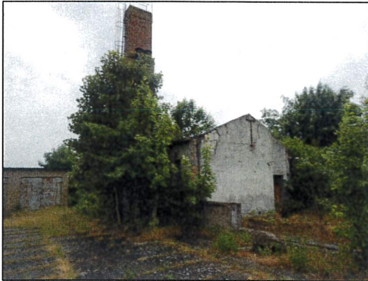
Bild 1: Gebäudeansicht Heizhaus von Westen.
