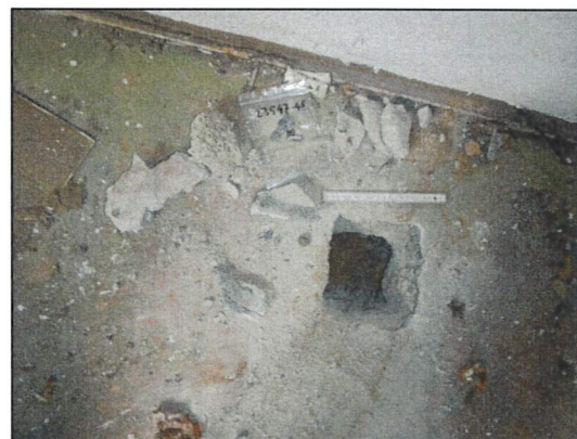
Bild 36: Wohnhaus II, EG, Wohnraum 1, Probe 23547-45, Teerpappe mit geringen Asbestgehalten und HWL im Fußboden.
