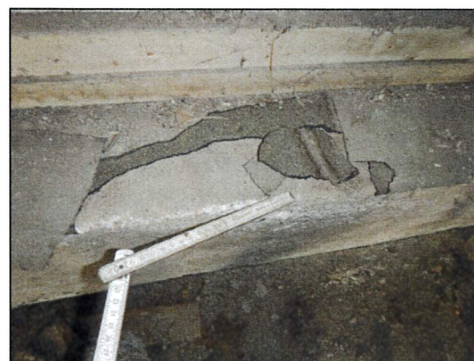
Bild 18: Bürogebäude I, EG, Raum K (Werkstatt), Probe 23547-12, asbestfreie Teerpappe als Horizontalsperre zwischen Betonsockel und Sandwich-Leichtbauplatte.
