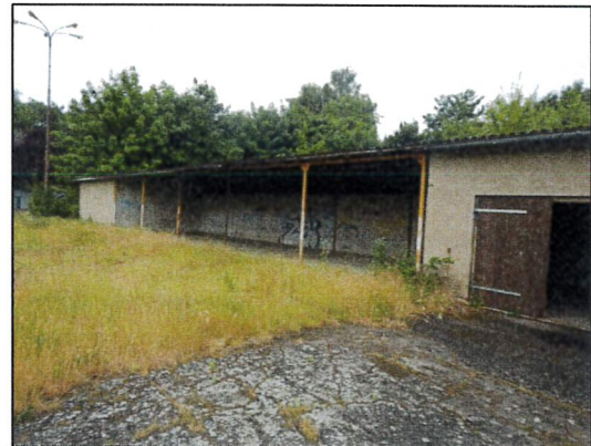
Bild 2: Gebäudeansicht Garagenkomplex (Südflügel) von Osten.
