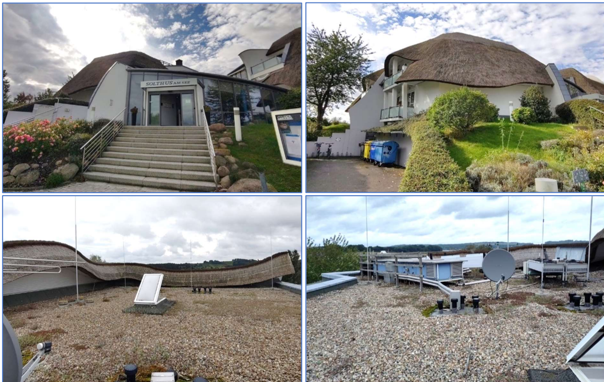
Abb. 6 bis 9 Gebäudeansichten und Dachflächen
