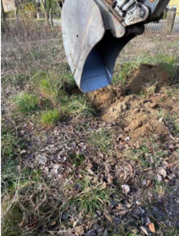
Anlegen eines Schurfes mittels Bagger auf Teilfläche F7
