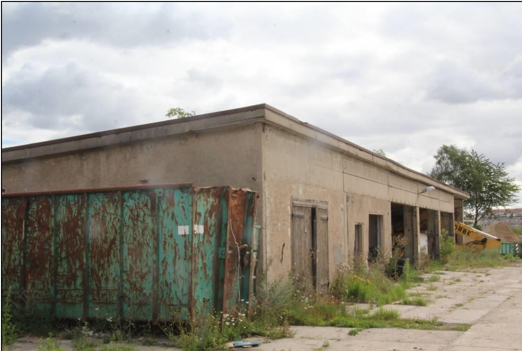
Abbildung 9: Mit Betonelementen gedeckte Halle (Gebäude 1a).
