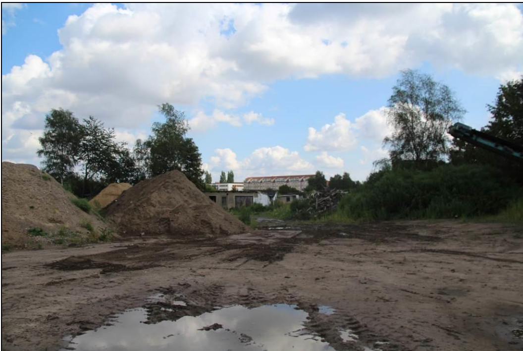
Abbildung 20: Ablagerungen von Erdstoffen östlich des Gebäudekomplexes 1.
