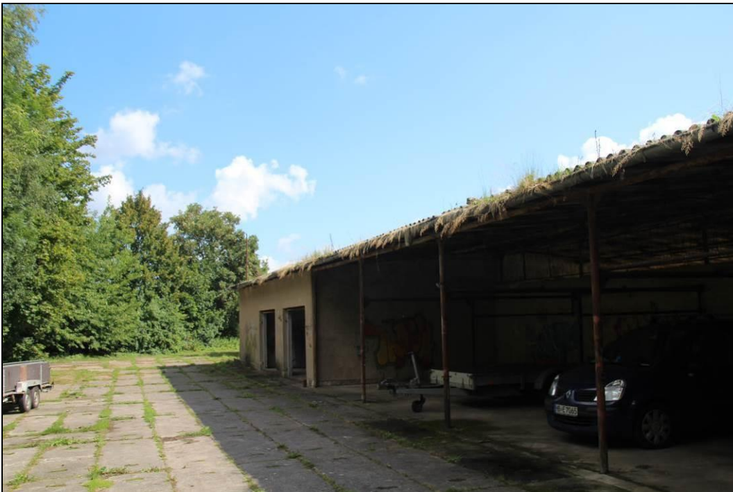
Abbildung 12: noch teilweise genutzte Halle des Gebäudekomplexes 2
