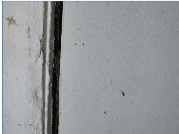
Abb. 22 Quartierspalt mit Fledermauskot an der Wand
