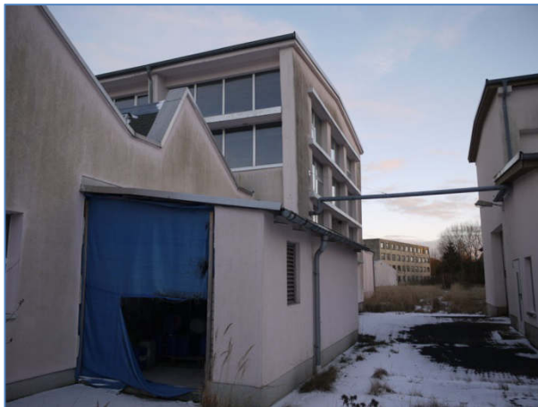
Abb. 21 Anbau mit Quartierspalt im Inneren
