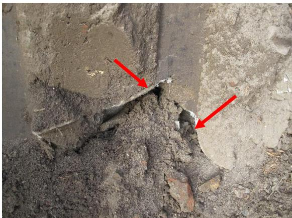
Bild 11: Detail zu Bild 10, Asbestzementbruch
