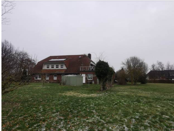
Abb. 1: Rückansicht des bestehenden Wohnhauses mit großem Zierrasenbereich, 17.01.2024.
